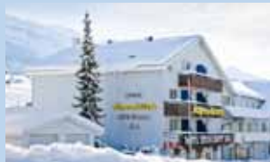
Hotel Alpenblick*** Ortsteil „Lisighaus“
